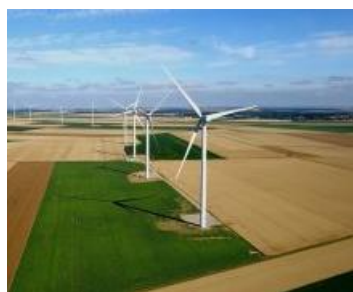
Parc éolien Santerre Energies 1
