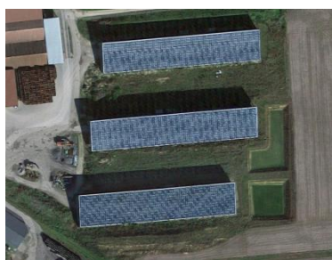
Toiture PV agricole à Brouchy 2
